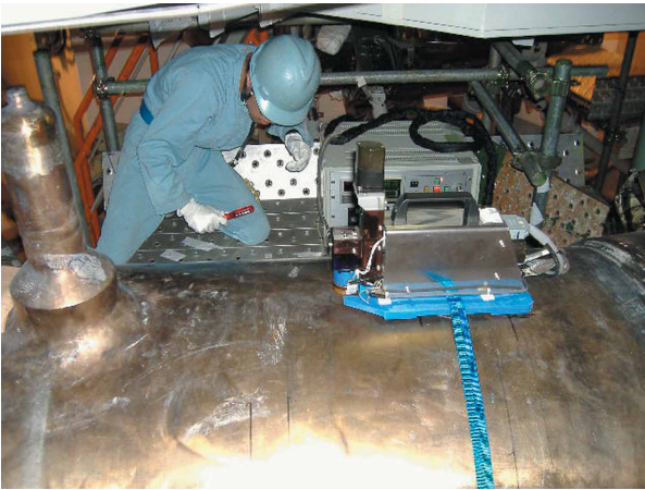
写真5 1次冷却材管における熱起電力測定作業
