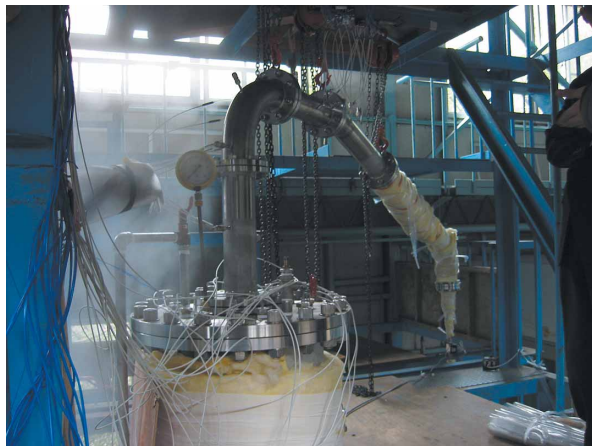
写真1 加圧器スプレイ配管の模擬実験
