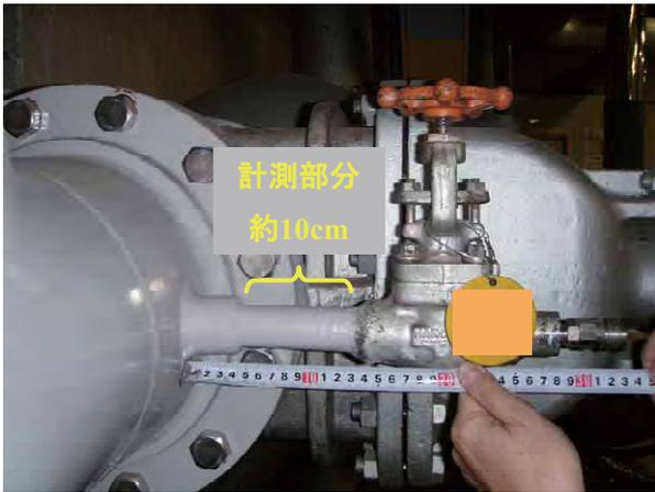
図4 実機振動測定箇所例
