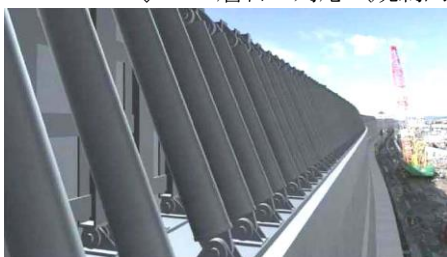
津波防護壁の設置 (津波を発電所構内に侵入させない。)
